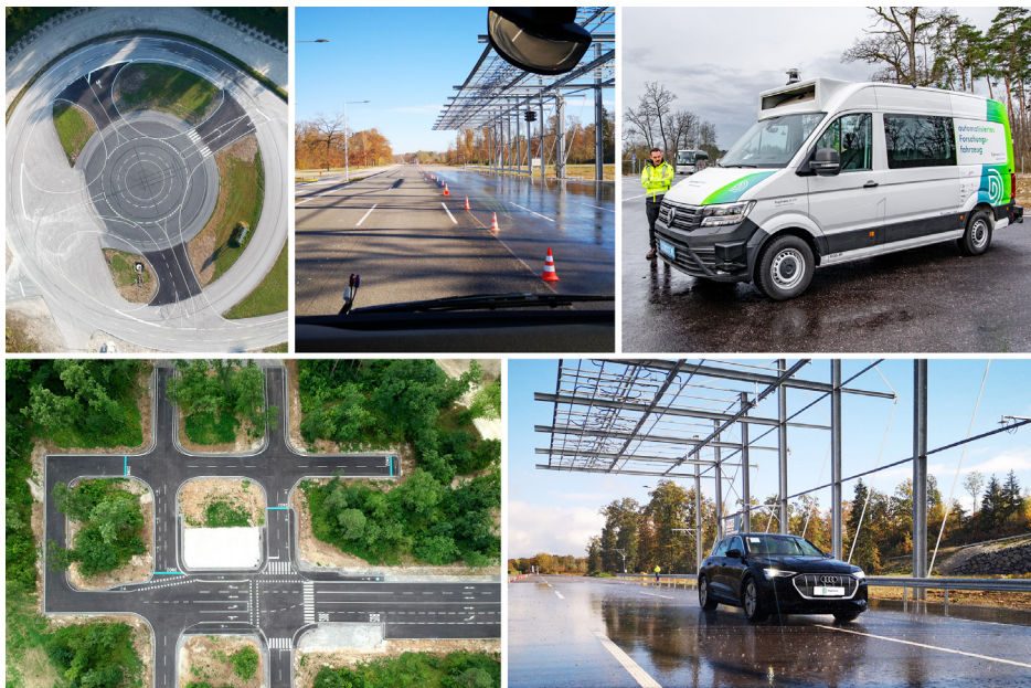
Kreisverkehr, City Zone, Beregnungsanlage und automatisiertes Versuchsfahrzeug Digitrans eVAN im Digitrans Testcenter auf der Teststrecke in St. Valentin ©DigiTrans GmbH
